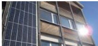
Strom erzeugen aus Sonnenenergie: 220 m<sup>2</sup> Photovoltaikelemente mit rund 40'000 Kilowattstunden Leistung pro Jahr erzeugen grünen Strom, der für den Eigenbedarf (Wärmepumpe, [Beleuchtung](#), etc.) verwendet oder bei einem Überangebot ins Netz eingespeist wird. Die Anlage ist bis 2015 um 35'000 Kilowattstunden erweitert worden.
