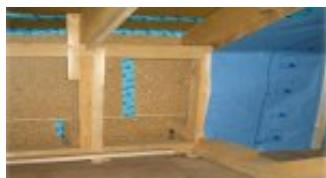
Die noch im Ständerwerk des Elementbaus vorhandenen Hohlräume wurden mit Zellulose ausgeblasen. Unzureichende Konstruktionen wurden aufgedoppelt und gedämmt. Die angestrebten U-Werte für Wände, Dach und Estrichboden liegen alle unter den geforderten Grenzwerten des [Gebäudeprogramms](#). (von 0.2 – 0.1 W/m<sup>2</sup>K) Die alten [Fenster](#) wurden durch moderne Holz-Metall Fenster mit einem U-Wert unter 0.7 W/m<sup>2</sup>K ersetzt.
