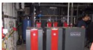
Ersatz der alten Ölheizung durch eine [Wärmepumpe](#). Die alten Öltanks mit einem Fassungsvermögen von
