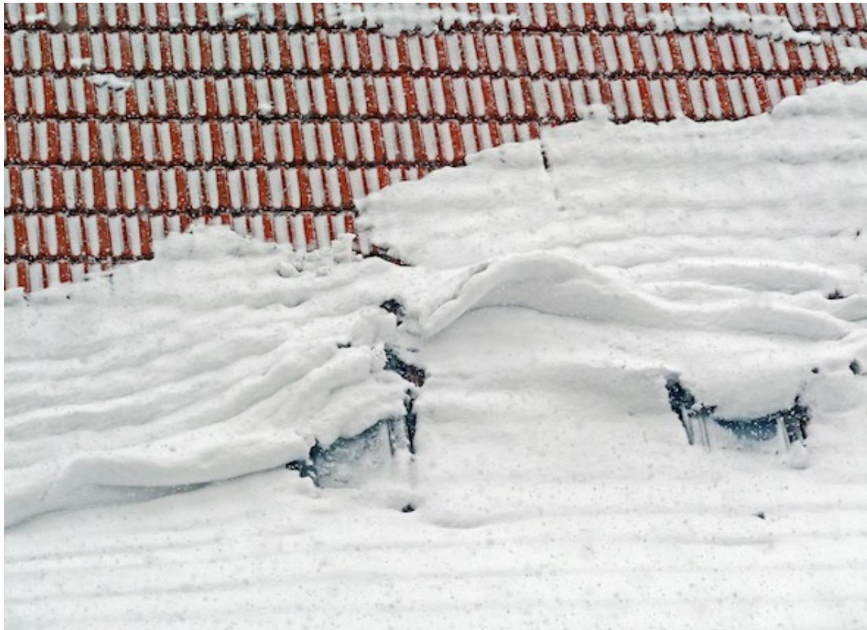
Genau wie beim Wind spielt die Dachneigung eine wesentliche Rolle bei der Resistenz gegen Schnee. Auf steilen Dächern können sich keine so dicken Schneekappen bilden wie auf flachen Dächern. Die Scheelast wird nach der EU-Norm Eurocode EN 1991-1-3 geregelt und durch weitere nationale Regelwerke ergänzt.
