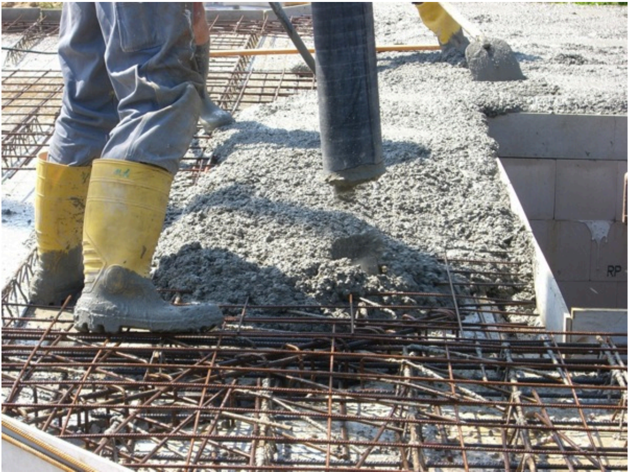
Industriebeton, Quelle: michael-metze.de
