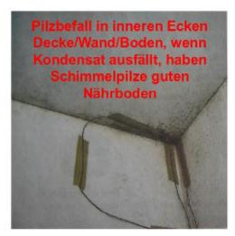
Isotherme in Ecken heikel, da Oberflächentemperatur tiefer als die Raumluft Lösung: Ecken ausrunden mit Dämmputz
