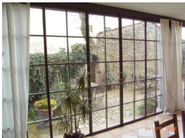
Fenster mit Stahlrahmen ermöglichen bei hoher Stabilität sehr schlanke Rahmen. Grosse Glasflächen benötigen aus statischen Gründen andere Konstruktionsmethoden (z.B. Glasfassaden an hohen Gebäuden sind besonders dem Winddruck und Windsog ausgesetzt).
