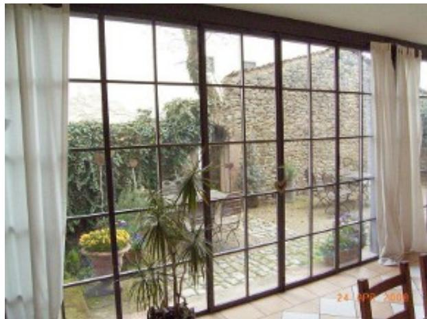
Fenster mit Stahlrahmen ermöglichen bei hoher Stabilität sehr schlanke Rahmen. Große Glasflächen benötigen aus statischen Gründen andere Konstruktionsmethoden (z.B. Glasfassaden an hohen Gebäuden sind besonders dem Winddruck und Windsog ausgesetzt).
