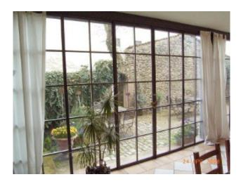
Fenster mit Stahlrahmen ermöglichen bei hoher Stabilität sehr schlanke Rahmen. Grosse Glasflächen benötigen aus statischen Gründen andere Konstruktionsmethoden (z.B. Glasfassaden an hohen Gebäuden sind besonders dem Winddruck und Windsog ausgesetzt).
