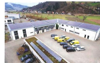
Die 100 kWp-Anlage im Schwarzwald mit dem neuen S-Class Vision von Centrosolar (Copyright: Kammerer Luft- und Wärmetechnik GmbH).
