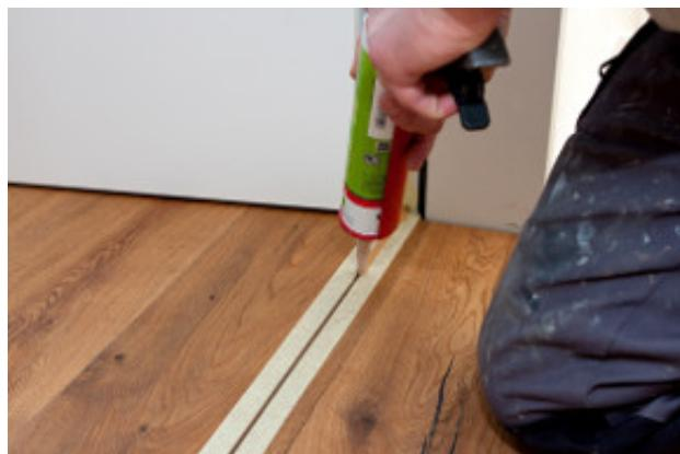
Gebräuchliche Dichtstoffe sind Silikon für den Sanitärbereich oder Acryl für Anschlussfugen. Beide Kunststoffe gehören in die Gruppe der Elastomere, welche elastisch, gute Wärmeleiter aber elektrisch leitend sind. Solch verschlossene Fugen können nicht absolut wasserdicht gelten.
