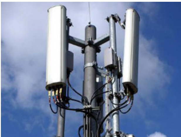
Mobilfunkmast mit den typischen drei Antennenteilen
