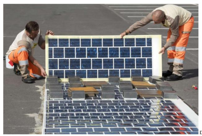
Wattway-Solarpanels für die Strasse sind nur 7 Millimeter dick und werden direkt auf den bestehenden Belag aufgebracht
