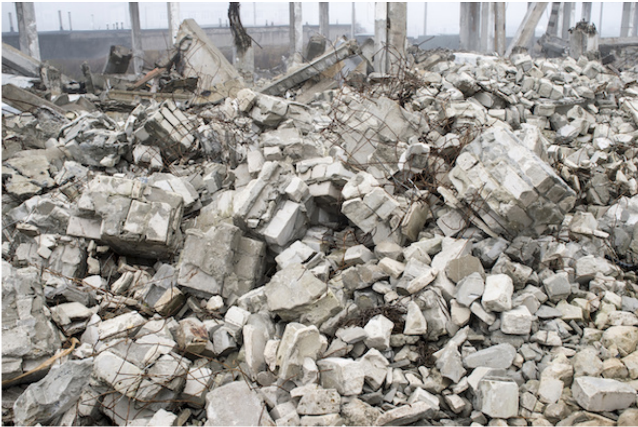
Betonbruch Rückgebautes Betongebäude. Bild Adobe Stock
