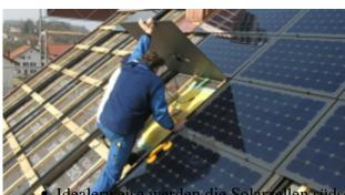
Idealerweise werden die Solarzellen südseitig mit einer Neigung von etwa 45° angebracht. Möglich sind aber auch Orientierungen zwischen Südost und Südwest mit Neigungen zwischen 15° und 60°.
