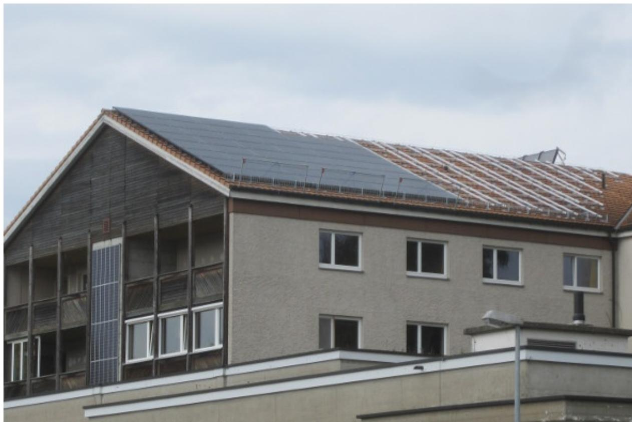
Oekodorf Degersheim: PV-Anlage im Bau; rechts Unterkonstruktion, links fertige Zelle auf das Dach aufgesetzt mit guter Hinterlüftung zur Wärmeabfuhr für bessere elektrische Leistung
