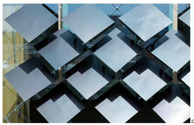
Solarfassade passt sich dem Sonnenstand an. Sie hängt an der Südseite des House of Natural Resources und dient gleichzeitig der Beschattung und der Energiegewinnung.
