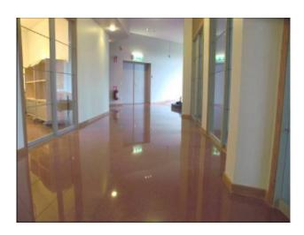
Baubiologisch und ökologisch einwandfreie Unterlagsböden bestehen aus Kalksand und Weisszement. Kalk als Grundstoff ist ein eher poröses Material. Dadurch haben diese Unterlagsböden bei gleicher mechanischer Belastbarkeit bessere Wärmedämmeigenschaften und eine grössere Elastizität als normale Unterlagsböden.
