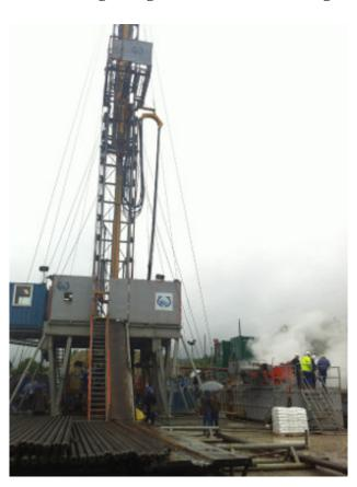
Die ersten Pumpversuche bei Grob Gemüse + Landbau hatten gezeigt, dass auf längere Zeit ungefähr 20 Kubikmeter 62 Grad Celsius heisses Thermalwasser pro Stunde gefördert werden können. Zukünftig möchte das Unternehmen Warmwasser aus dem Erdinnern als Heizung nutzen. Für die zweite Bohrung erhofft das Unternehmen sich noch bessere Werte.
