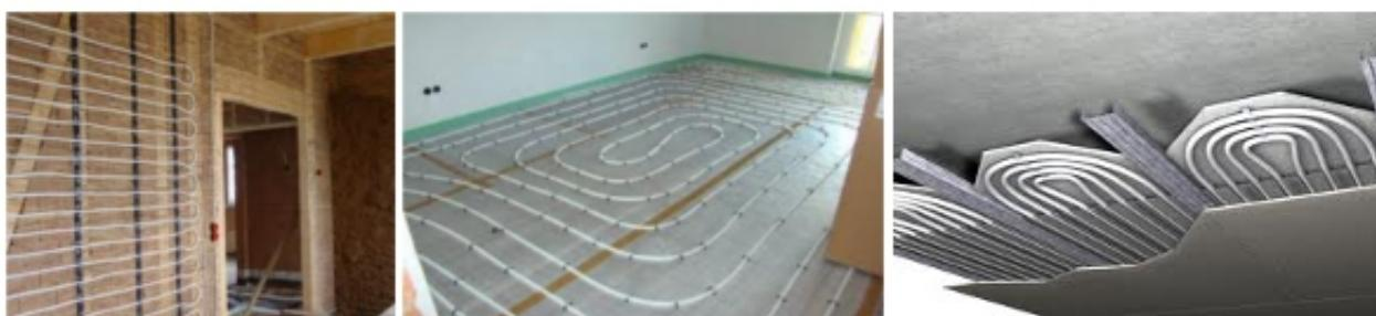
Wand-, Fussboden- oder Deckenheizungen verbreiten schon bei verhältnismässig geringen Heiztemperaturen eine behagliche Strahlungswärme bei geringer Konvektionsleistung. Die Heisswasser führenden Leitungen sind hierbei in Wand, Fussboden oder Decke verlegt.
