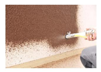
Ob dünn oder dick aufgetragen, Strohfasern und Wasser werden zu einem spritzbaren Putz oder einer fugenlosen Wandbekleidung. Angenehme Raumluft und Feuchtigkeitspuffernd, ob fugenlos aufgetragen oder als vorgefertigte Paneele in frei wählbaren Designs, der neue Baustoff fügt sich gut in die Reihe der baubiologischen und ökologischen Materialien ein.
